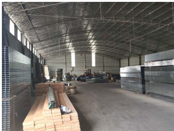
现有项目车间内部
