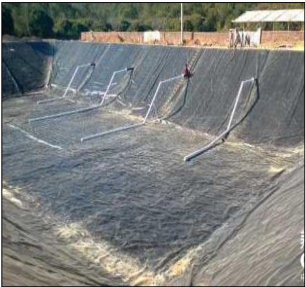
图 5-4 黑膜沼气池内部示意图
