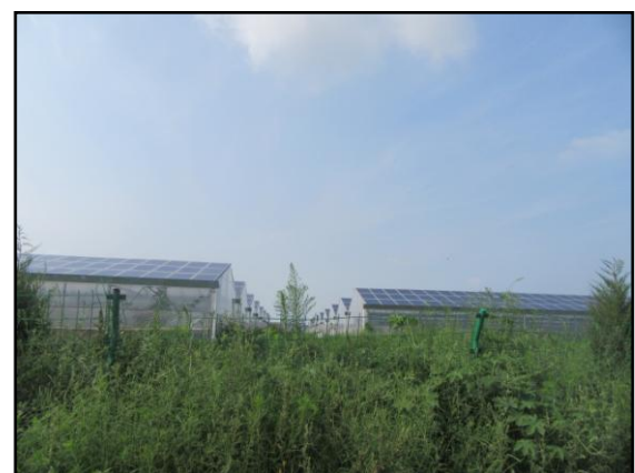
场址东侧光伏发电区
