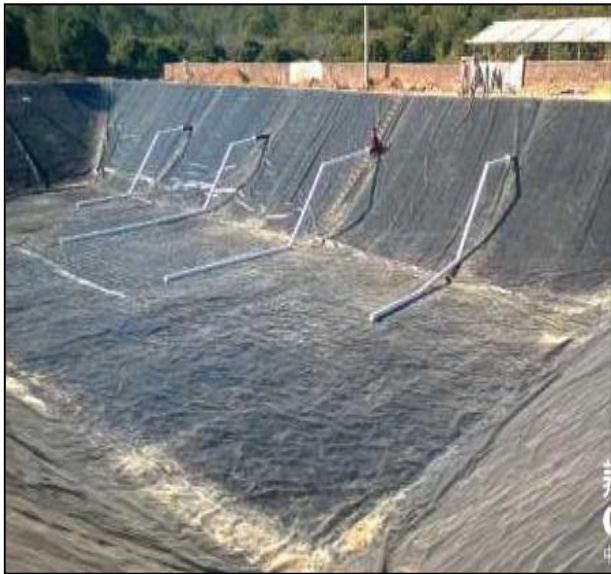
图 5-4 黑膜沼气池内部示意图
