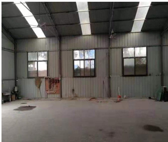
生产车间内部
