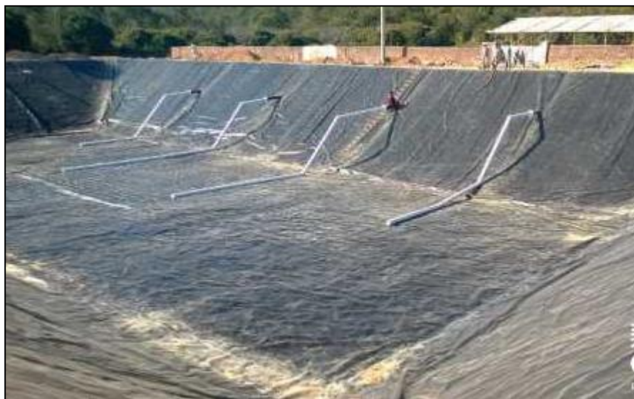
图 5-2 黑膜沼气池内部示意图
