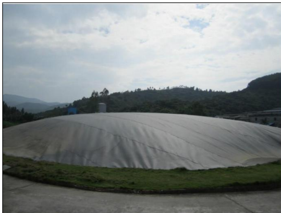
图 5-3 建成后的黑膜沼气池示意图
