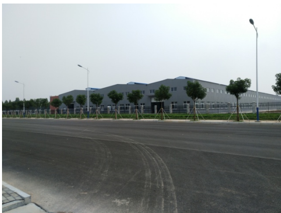
项目厂区东侧
