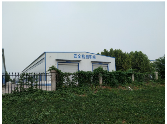
项目厂区北侧顺泽检测公司
