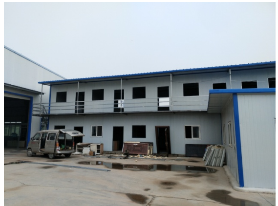
项目厂区办公室
