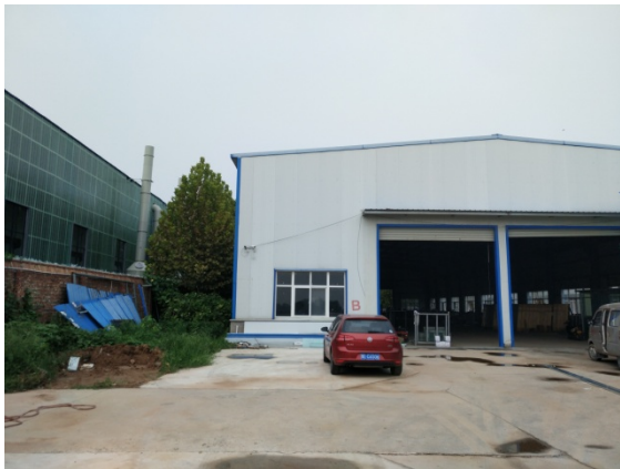
项目厂区生产车间
