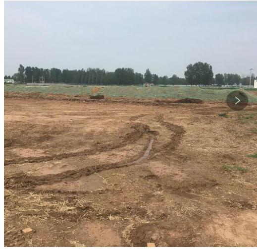
项目所在厂区现状
