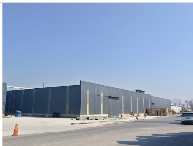
项目东侧厂界闲置厂房
