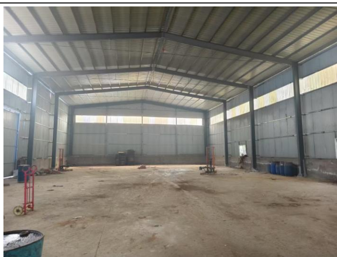
挤出车间内部现状
