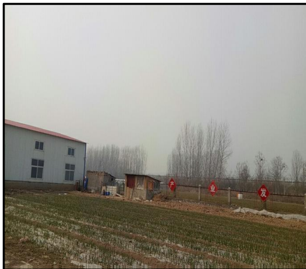
厂区西侧（高速公路）
