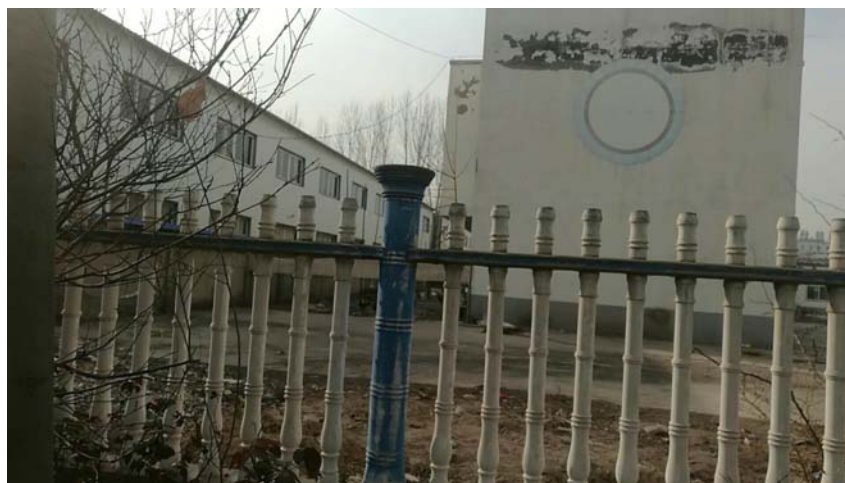
本项目南侧厂房
