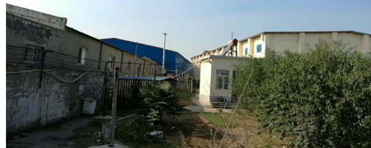
本项目南侧厂房
