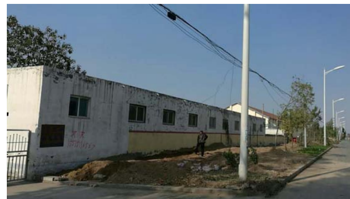
本项目北侧厂房
