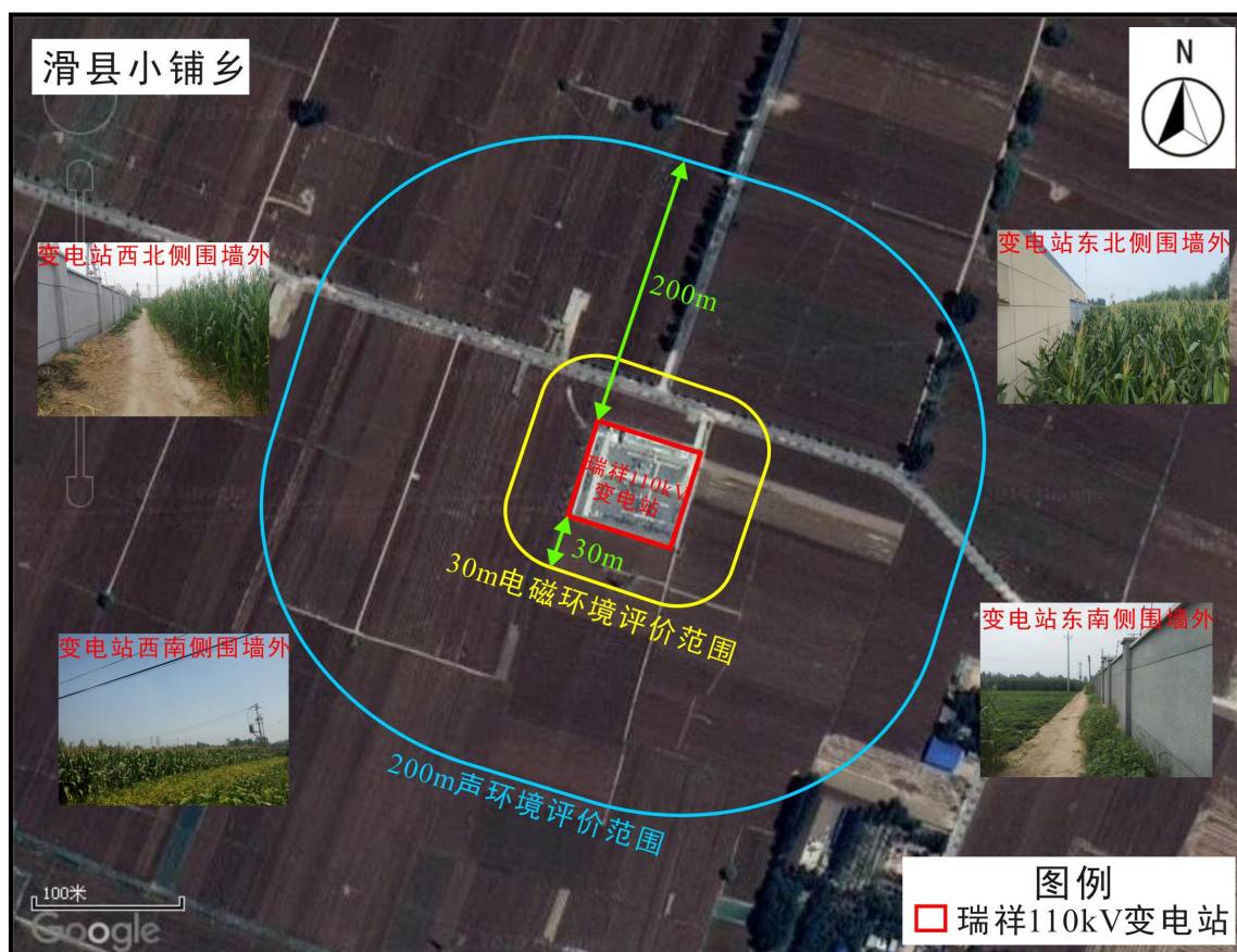
图 3-1 瑞祥 110kV 变电站周围环境情况卫星图
