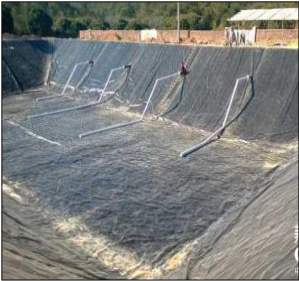
图 5-4 黑膜沼气池内部示意图
