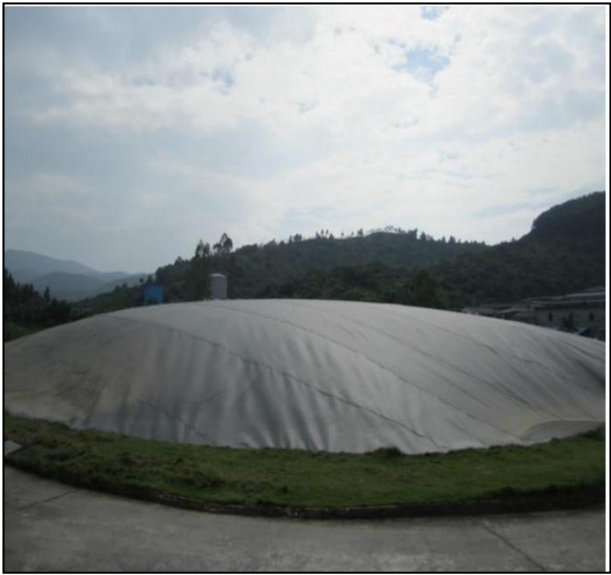
图 5-5 建成后的黑膜沼气池示意图
