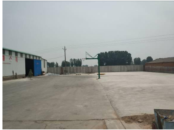
项目厂区内部
