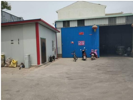
项目厂区内部
