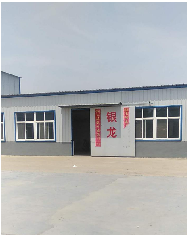
项目厂区现状
