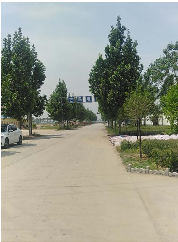
项目南侧园区道路
