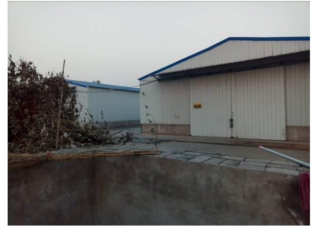
项目北侧空厂房
