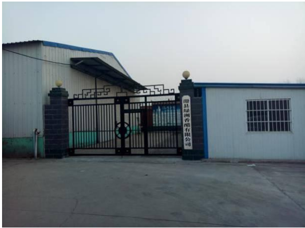
项目南侧停工的醋厂
