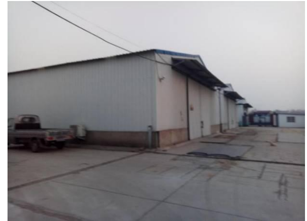
项目 1#生产车间
