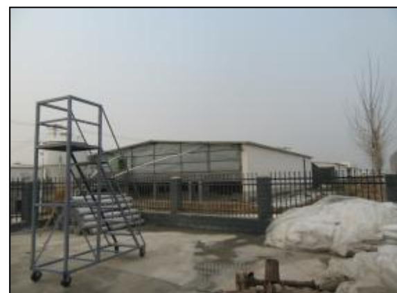
现有工程现状
