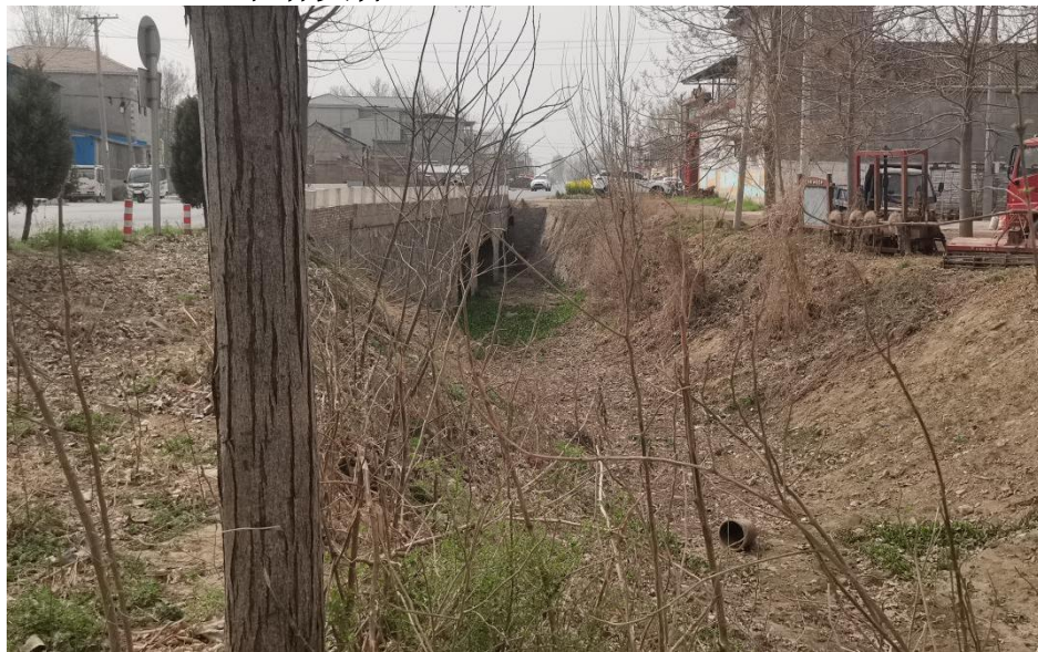
桩号 K3+487 涵洞及岳村沟现状
