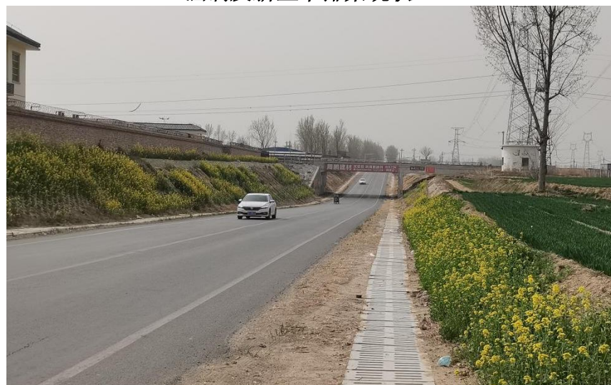
桩号 K1+747.78 处下穿滑县专用铁路框架桥
