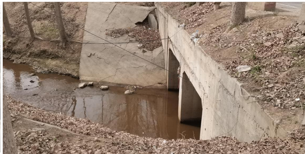
K0+223 涵洞及新五千排渠现状
