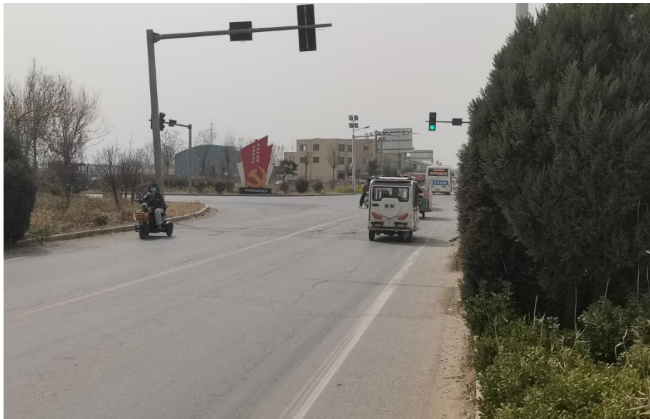
项目终点桩号 K7+323.600 及道路现状照片
