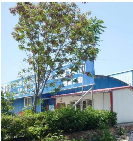
项目南侧超强箱体
